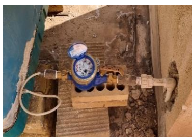
تصویر ۶: نمایی از اتصال کنتور آب (مأخذ: نگارندگان)
