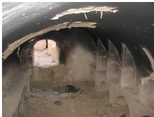
تصویر ۱۵: یکی از فضاهای زیرزمینی با روزنه‌ای مقابل پلکان ورودی برای ارتباط با واحد معماری پشت آن (مأخذ: نگارنده اول، ۱۳۸۸)
