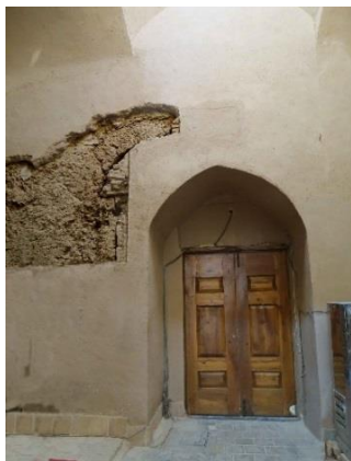
تصویر ۱۰ و ۱۱: مسجد جامع میبد. بقایای ورودی مسجد نخستین با چفد بیضی چانه‌دار (عکس‌ها از نگارنده).
