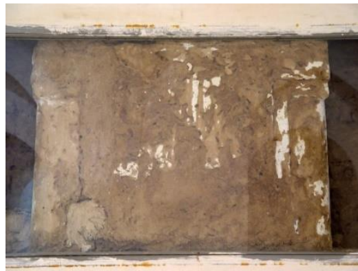
تصویر ۳۴ و ۳۵: بقایای جرزهای مسجد نخستین ابرکوه پس از لایه برداری. بر نبش جرزها پیلک کار شده است (عکس راست از نگارنده، چپ از رضا رحمانی).
