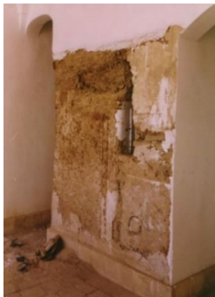
تصویر ۳۴ و ۳۵: بقایای جرزهای مسجد نخستین ابرکوه پس از لایه برداری. بر نبش جرزها پیلک کار شده است (عکس راست از نگارنده، چپ از رضا رحمانی).
